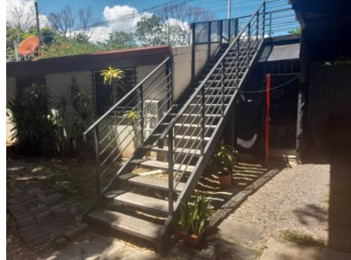
Núcleo de escaleras a segunda planta
