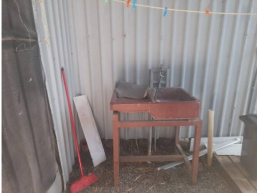
Área de pilas apartamentos
