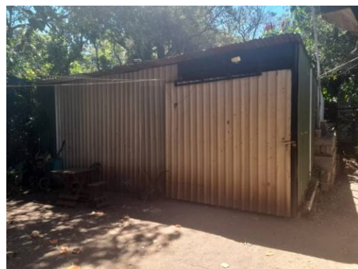
Bodega en el extremo suroeste
