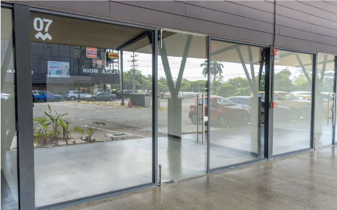
Fachada frontal local FF7
