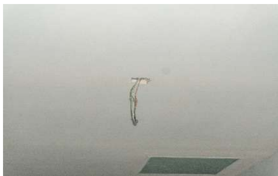
Detalle de prevista para iluminación
