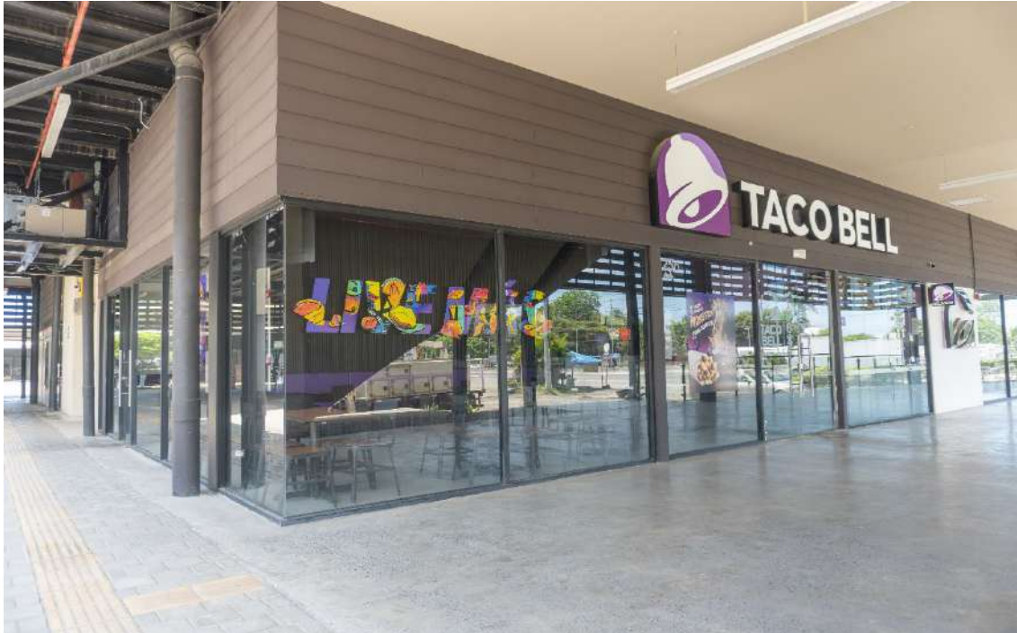
Vista Frontal del los locales FF26, FF27 y 25-B
