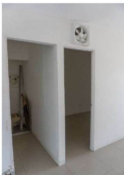
Área interna construida (Entrada)
