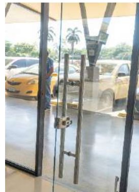
Detalle de puerta en vidrio temperado (y fachada frontal en
