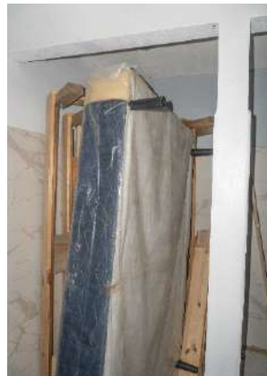
Duchas y sanitarios sector este local FF8
