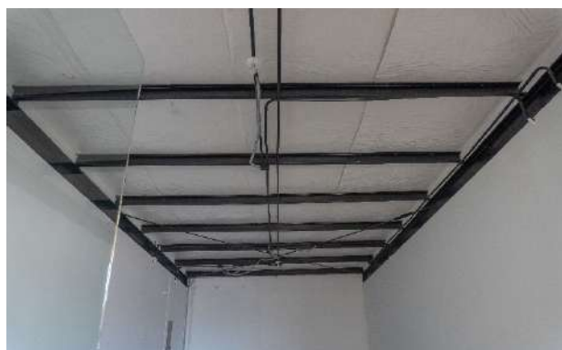
Cielo Raso Local FF14
