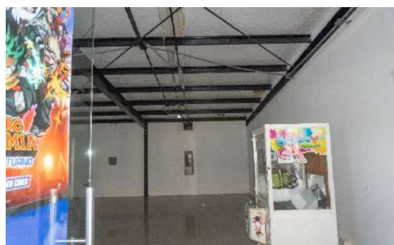
Vista interna general del local
