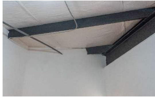
Cielo raso área de almacenamiento
