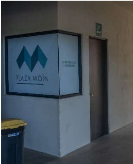
Entrada a cuarto de Vigilancia (Contiguo a Sanitarios)
