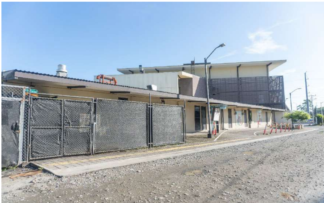
Vista general del costado oeste de las instalaciones, desde la esquina superior izquierda
