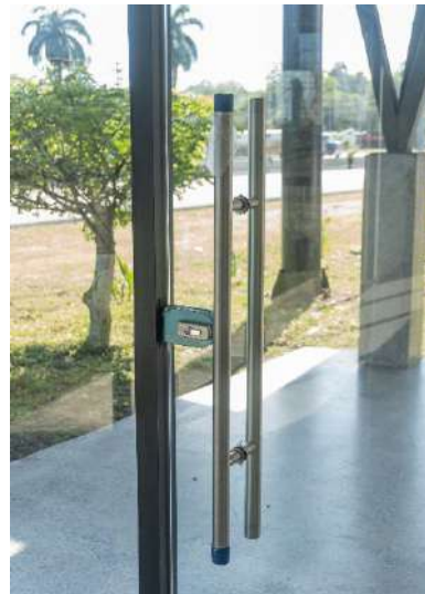
Detalle de material de paredes de fachada (Vidrio temperado y aluminio)
