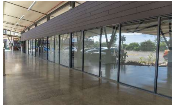
Pasillo (Vista desde local FF9 hasta el local FF13)
