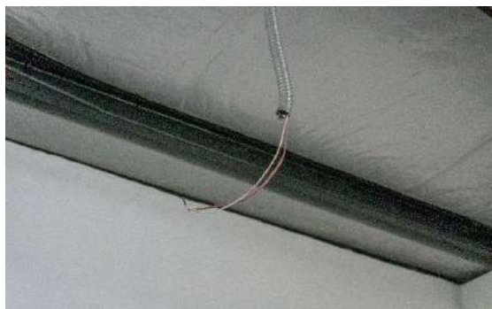
Detalle de prevista para iluminación
