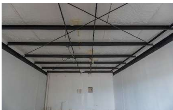
Cielo Raso Local FF9
