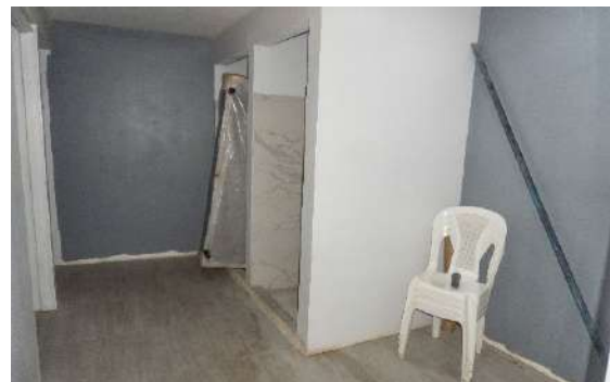
Duchas y sanitarios sector este local FF8
