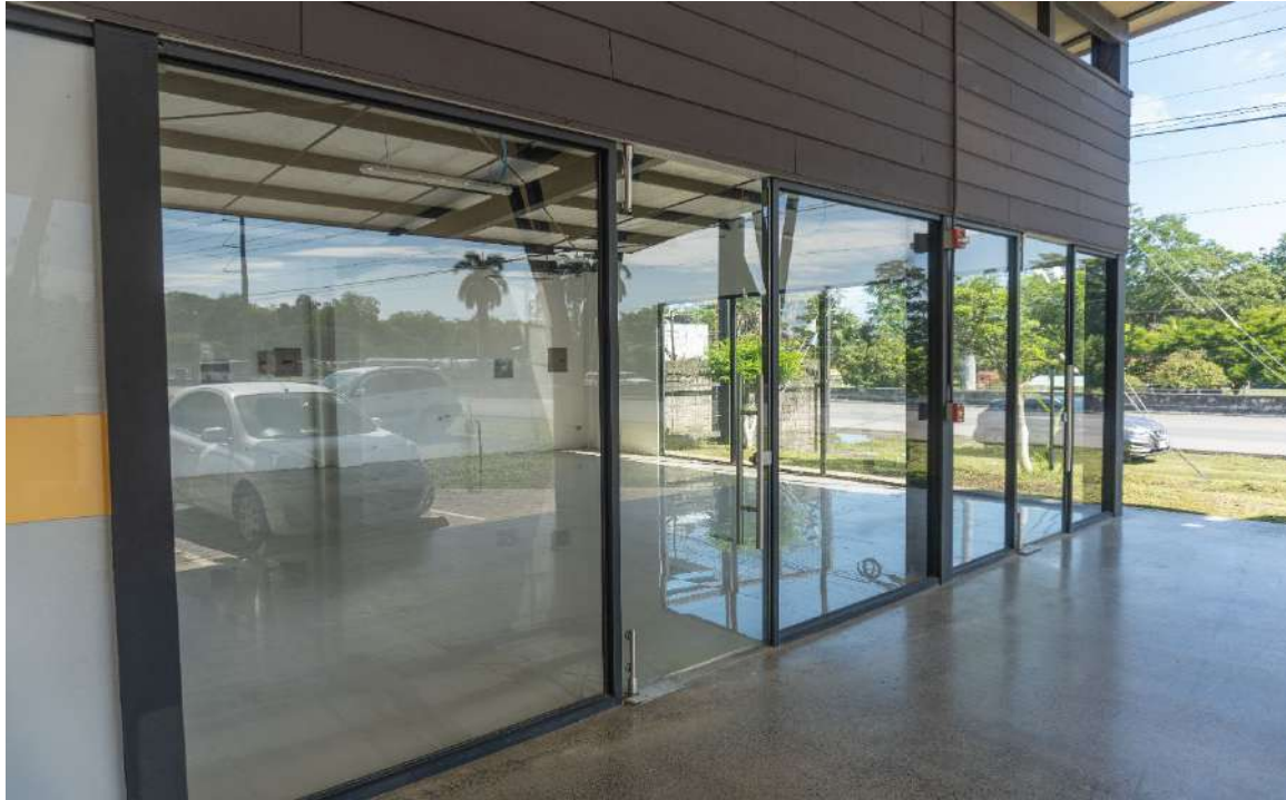
Fachada frontal de locales FF1 Y FF2
