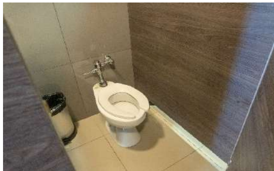
Vista de batería 2_3 en sanitario femenino
