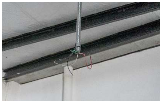
Detalle de prevista para iluminación
