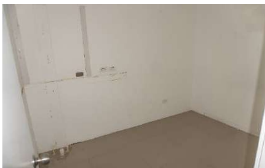
Área interna construida (Sala de masajes) interna
