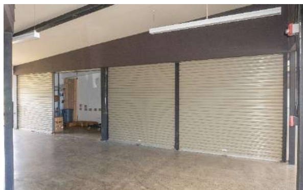
Fachada Lateral izq Local de los locales K-1 y K-2
