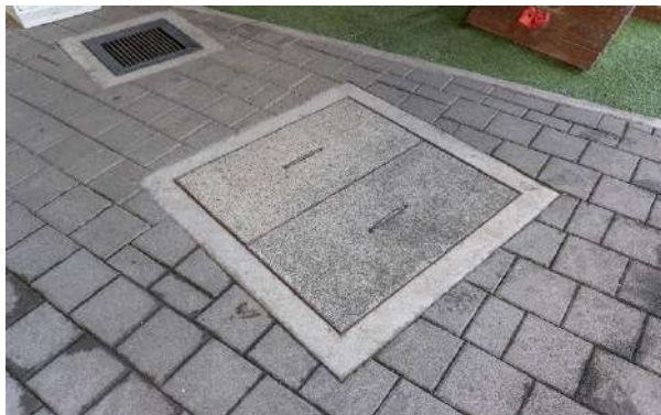
tapas de concreto y metal para la planta de tratamiento, debajo del parqueo
