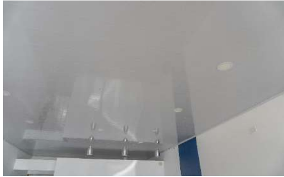
Cielo Raso Local FF5
