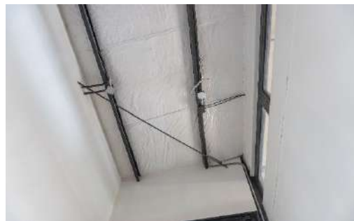
Cielo raso (Ingreso al local FF8)
