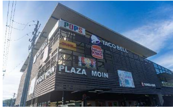
Vista Parcial de dos fachadas (Frente a la carretera y frente al parqueo)
