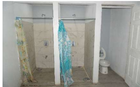
Duchas y sanitarios sector oeste local 8
