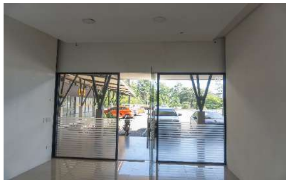
Contrafachada local FF10
