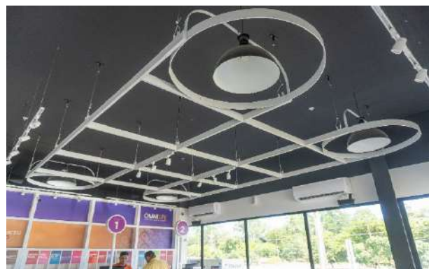
Vista del cielo raso y luminarias del local
