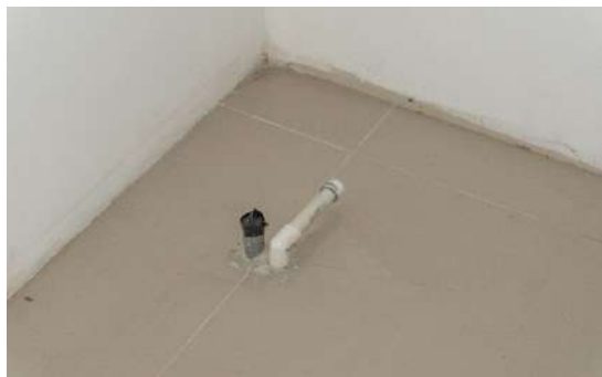
Previstas de tubería para agua
