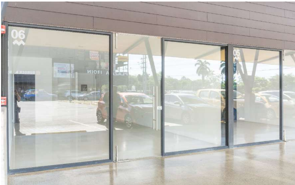
Fachada frontal Local FF6
