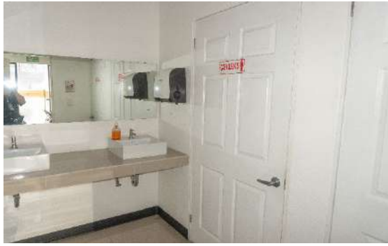
Sanitarios locales FF3 y FF4
