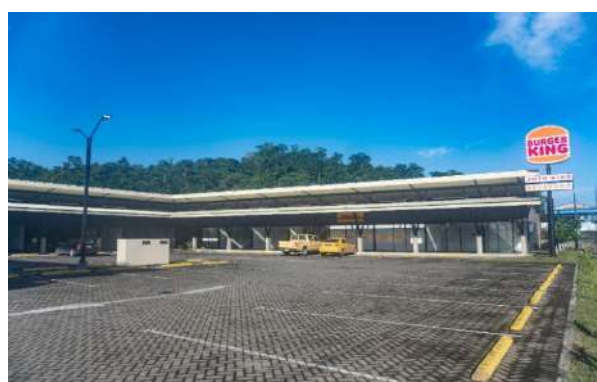
Vista general de locales del uno al ocho, desde el parqueo
