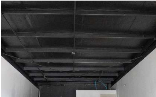
Cielo Raso Local FF7
