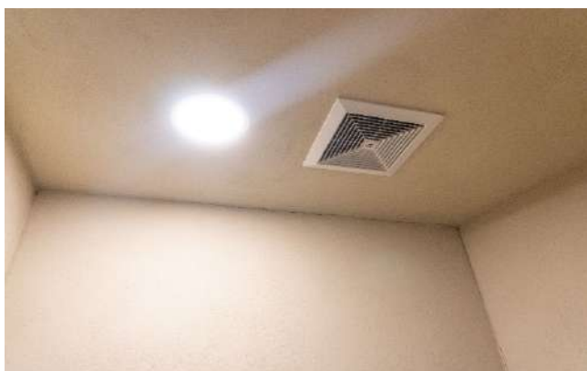
Cielo Raso y extractor en sanitario de cuarto de vigilancia
