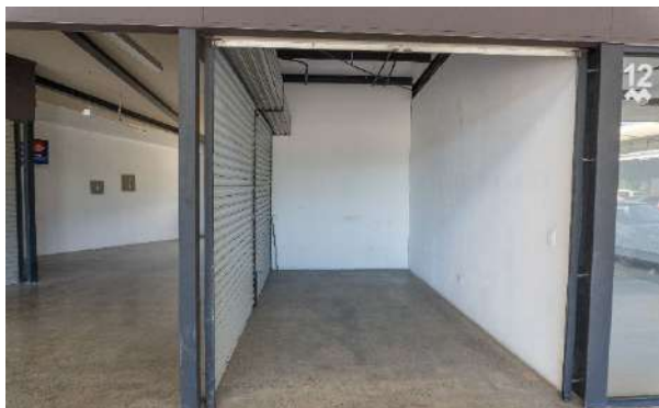
Fachada Frontal Local K-2 (Bodega)
