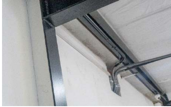
Detalle de soldaduras estructurales
