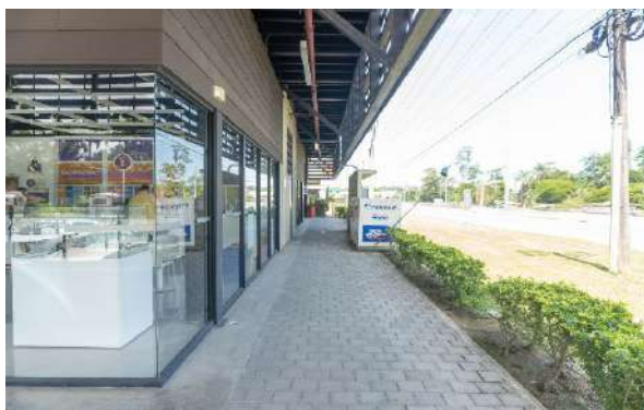
Vista de pasillo que bordea el lado derecho del local 25-A, donde da al parqueo y a Los locales del FF21 al FF24 (También donde están los medidores y el generador eléctrico 1)
