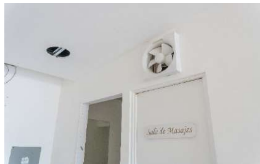
Área interna construida (Entrada)
