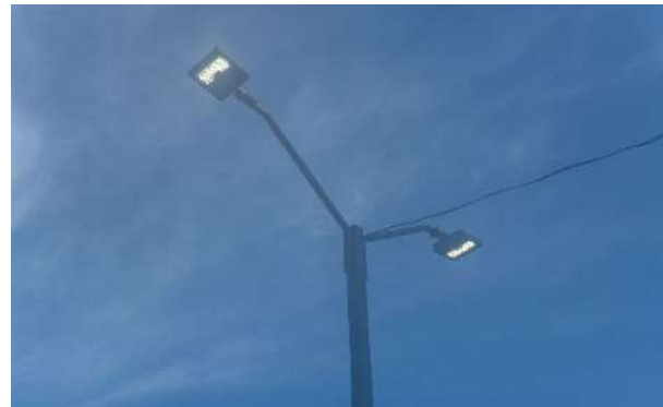
Detalle de Iluminación del parqueo (Luminarias led)
