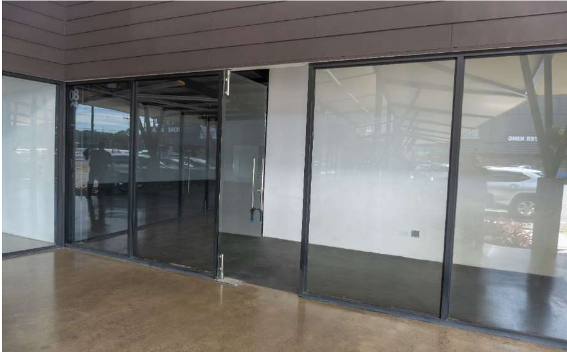
Fachada frontal Local FF8
