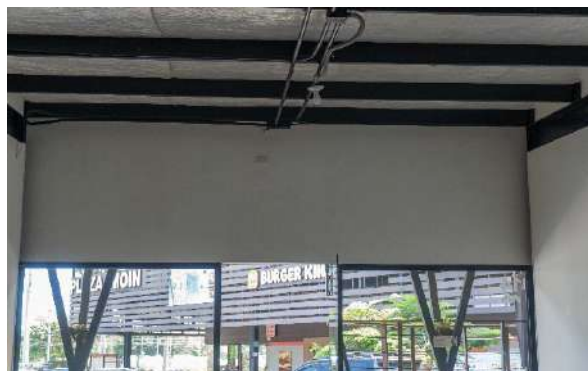
Contrafachada Local FF14
