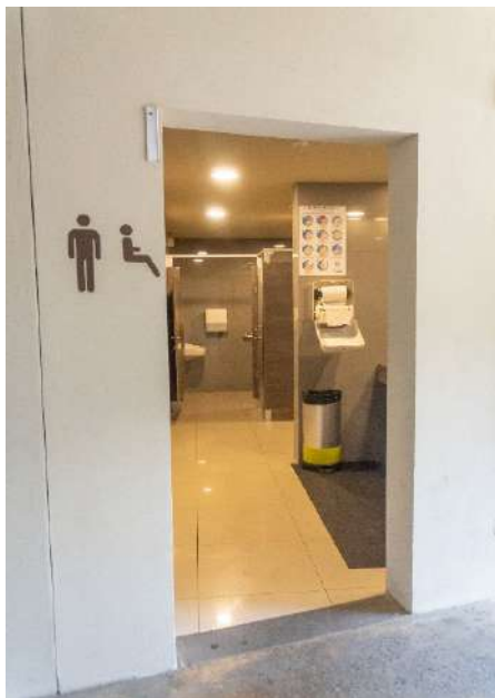
Entrada a sanitarios masculinos
