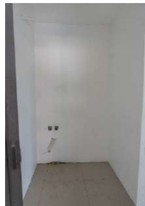
Construcción Interna Local FF6 (Dentro)
