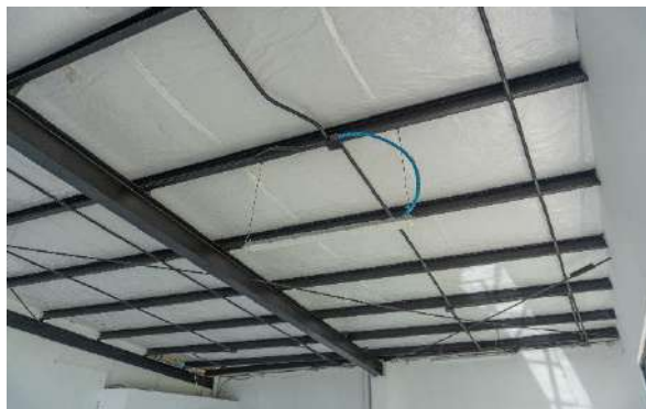
Cielo raso de locales FF1 y FF2 otra perspectiva
