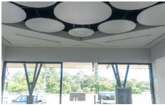
Contrafachada local FF12
