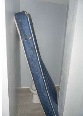
Duchas y sanitarios sector este local FF8
