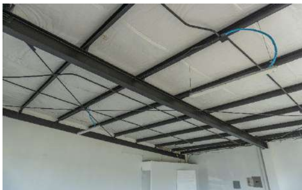
Cielo raso de locales FF1 y FF2 metal
