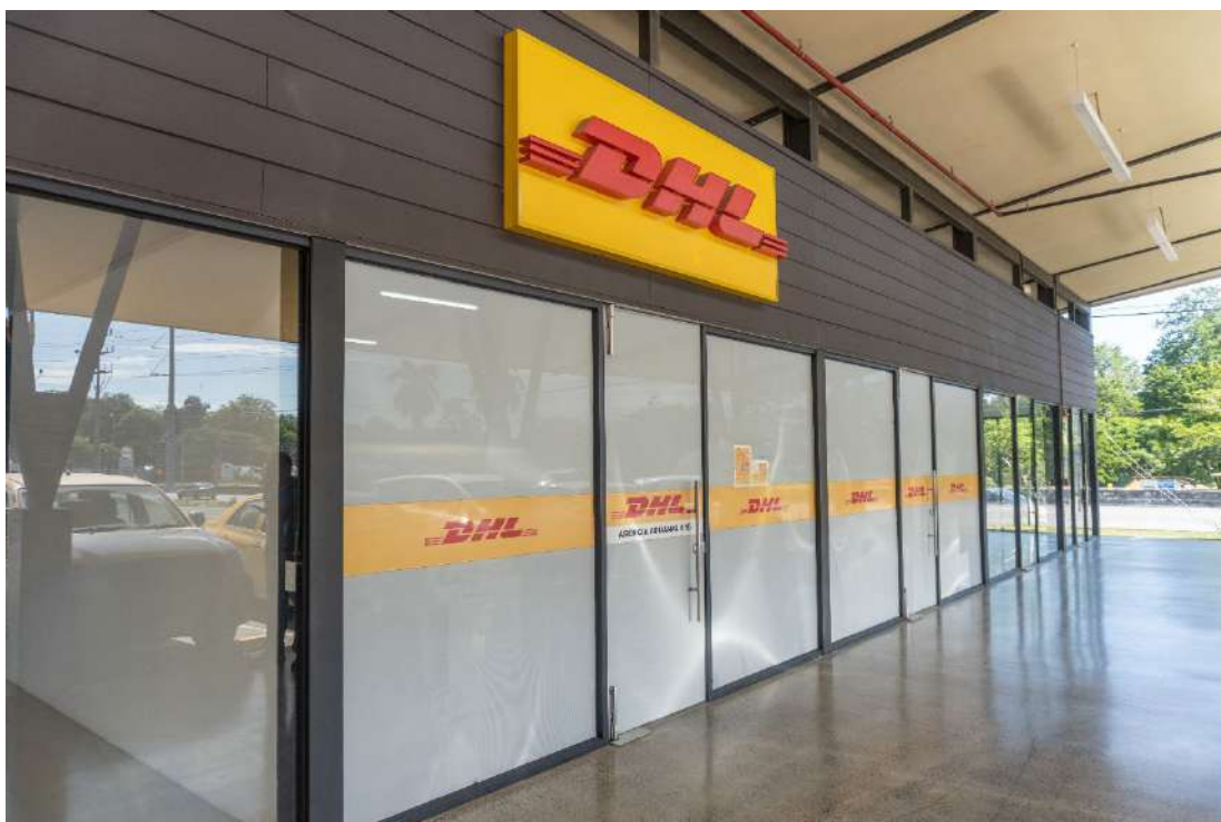
Fachada de locales FF-3 Y FF-4 (Ocupados por DHL)
