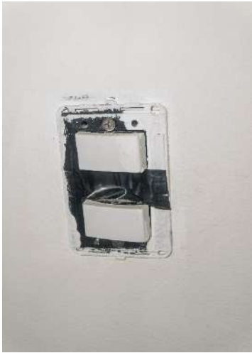
Detalle de estado de apagadores local FF15
