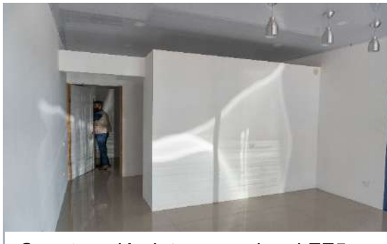
Construcción interna en local FF5
