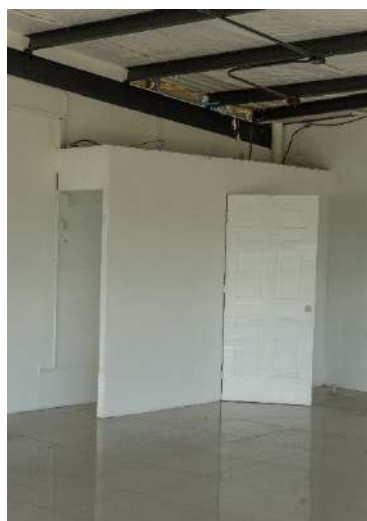
Construcción interna en local FF1 y FF2
