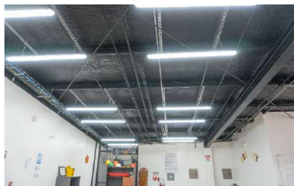
Cielo raso de local FF4
