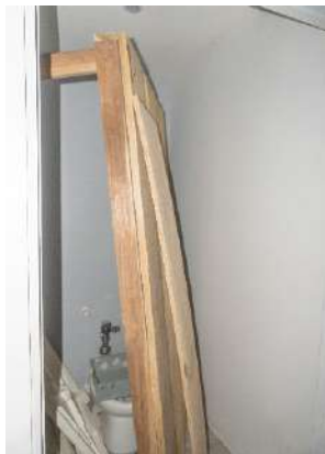
Duchas y sanitarios sector este local FF8
