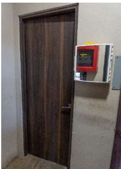
Entrada a sanitario en cuarto de vigilancia
