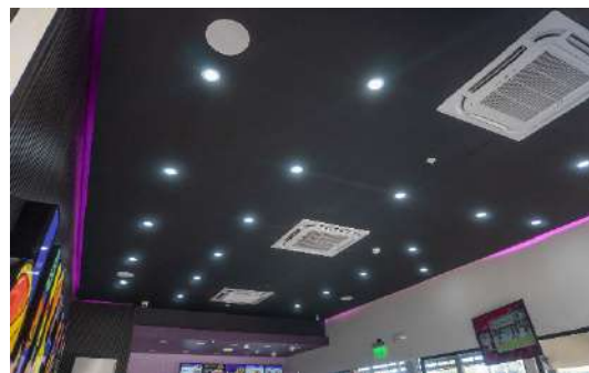
Cielo raso de locales
