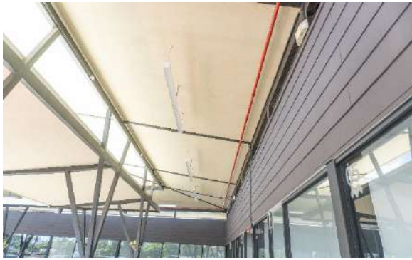
Detalle de acabados en fachadas y cielo rasos internos pasillo locales se pueden apreciar desde el local FF5 hasta el FF14
