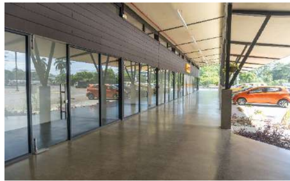
Pasillo (Vista desde local FF8 hasta local FF1)
