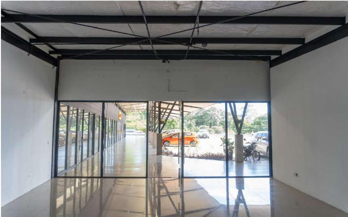
Contrafachada local FF9
