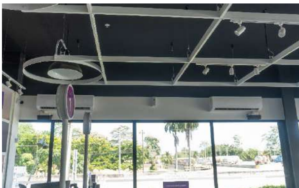
Vista del cielo raso y luminarias
