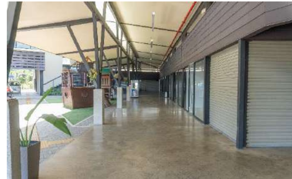
Pasillo (Vista desde local K-2 hasta el local FF17)
