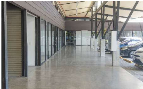
Pasillo (Vista desde local K-3 hasta el local FF8)
